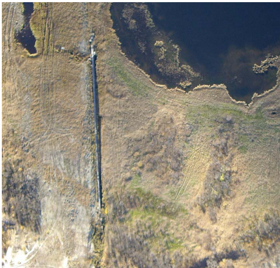
Рисунок 3. Участок магистрального газопровода с «провисом» трубы
