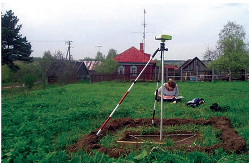
Рис. 6. Спутниковые наблюдения на маркированном опознание. Составление абриса
